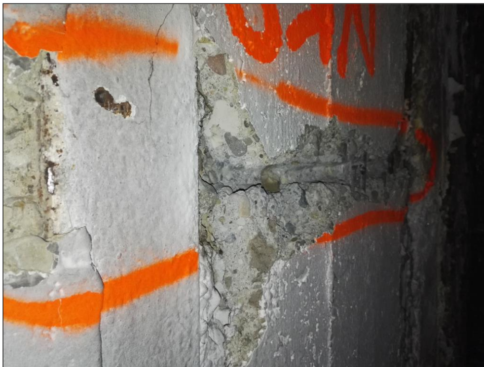
Obr. č. 14 - detailní pohled na spodní líc NK v levé části objektu s obnaženou spodní pásnicí ocelových nosníků. Střed fotografie zachycuje sondu do pro ověření výztuže.
