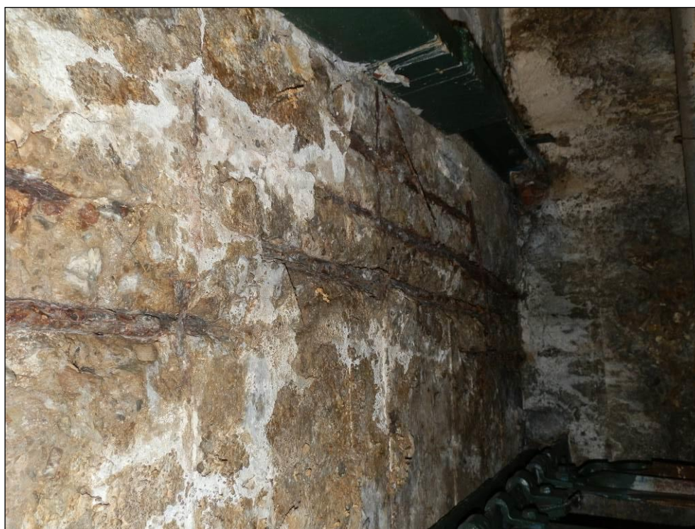
Obr. č. 13 - detailní pohled na spodní líc NK v pravé části objektu v místě průsaků vody NK, opadů krycí vrstvy a hloubkové, místy až extrémní koroze tahové výztuže při spodním líci NK.
