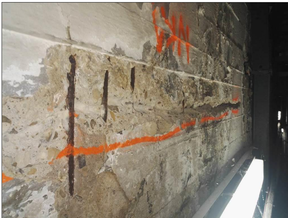
Obr. č. 12 - detailní pohled na spodní líc NK v pravé části objektu. Střed fotografie zachycuje sondu pro ověření výztuže.
